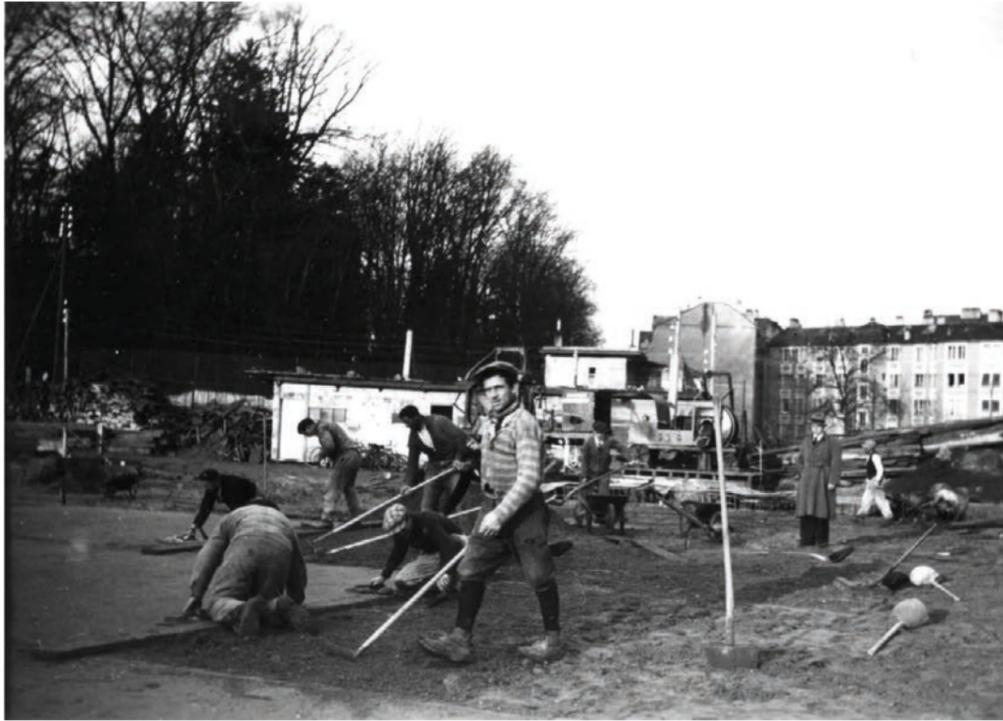
O. Nivellage de la piste remblayée, Sable fin tiré à la règle, pente 25 cm sur 65ml de l'est à l'ouest, 1938 (Photo C.K Pilet).
