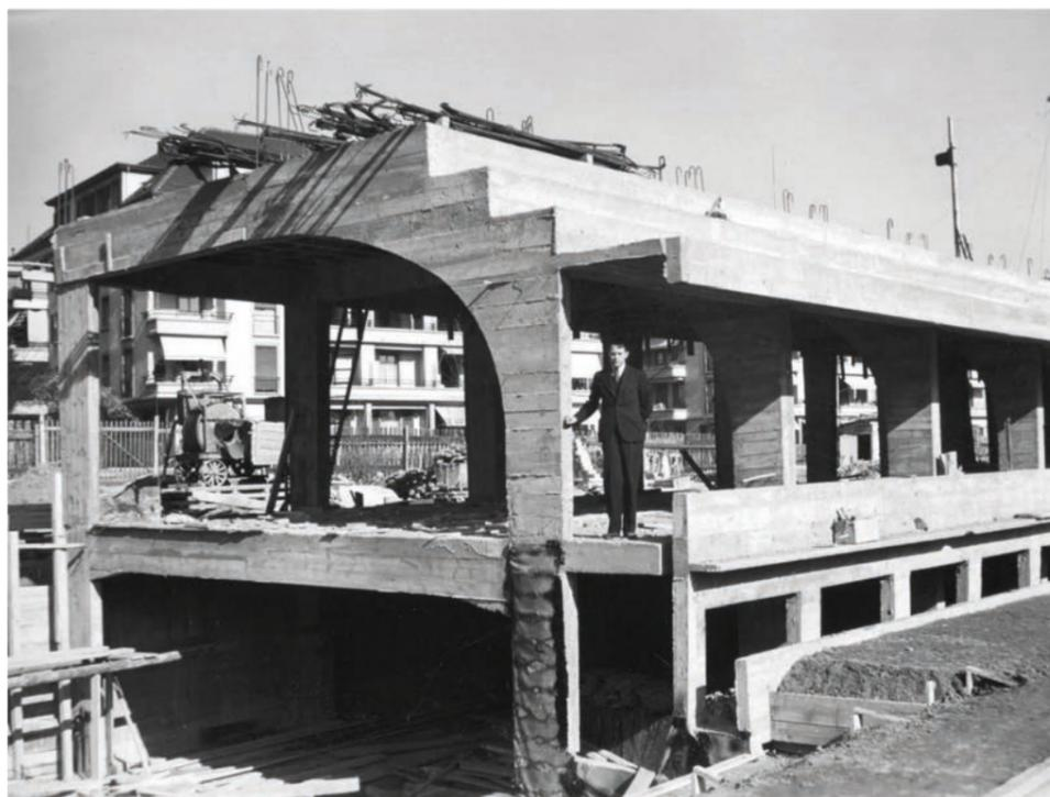
K. Le bâtiment du restaurant en chantier, structure en béton armé, début mars 1936. On observe le sous-sol destiné aux vestiaires, les sommiers arqués du restaurant et l'amorce des gradins. (Photo E Richard, conducteur des travaux).
